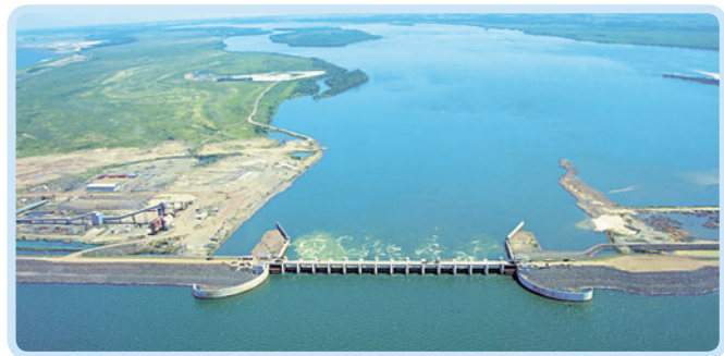
Vista aérea de la represa del Complejo Hidroeléctrico Yacyretá-Apipé.
