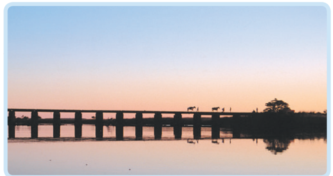
Puente sobre el río Miriñay.
