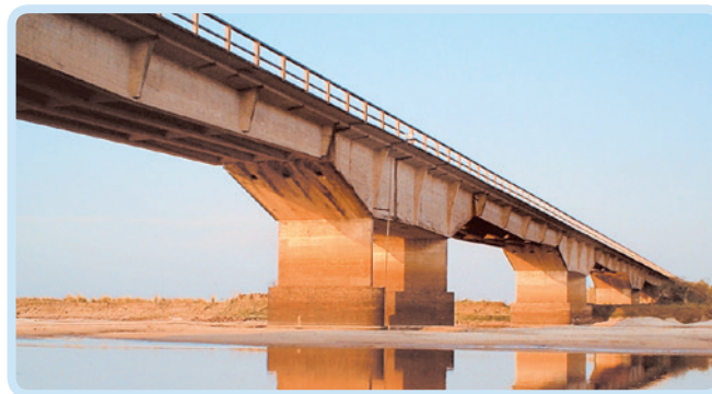
Puente sobre el río Corrientes.
