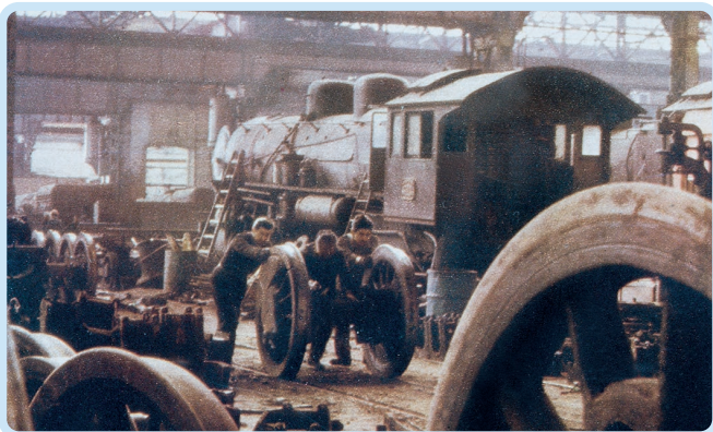
Obreros trabajando en los talleres del Ferrocarril Central Norte.
