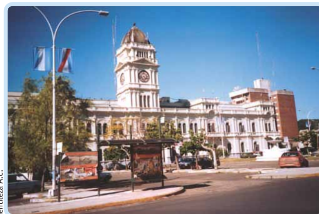
Casa de Gobierno de la provincia de Entre Ríos.
