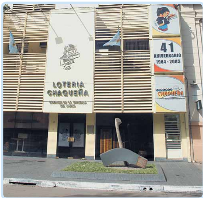
Sede de la Lotería Chaqueña en la ciudad de Resistencia.
