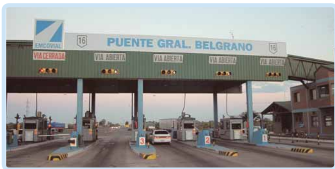
Acceso al puente General Manuel Belgrano, que une las ciudades de Resistencia y Corrientes, inaugurado en 1973.
